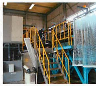
写真-12 有害廃液処理棟内
