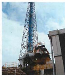
写真-11 排煙煙突
