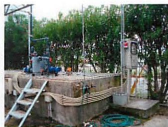
写真-3 廃液分離槽
