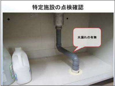
排水口の配管部分を点検・確認
