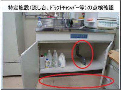
a. 特定施設(実験流し及び「ドラフトチャンバー」等)(対象となる特定施設は、Excel形式でのリストが存在するH25年の下水道法に基づく届出時の特定施設とします) 床までの配管と床面
